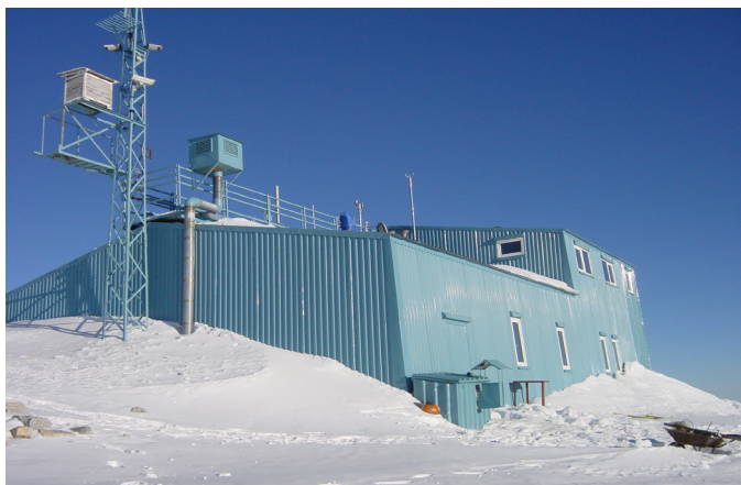
Фиг. 1 Общ вид на установката за пробовземане - горе устройството за филтърна материя, долу вляво въздушната турбина. По този начин се избягва рецикулация на въздуха.
